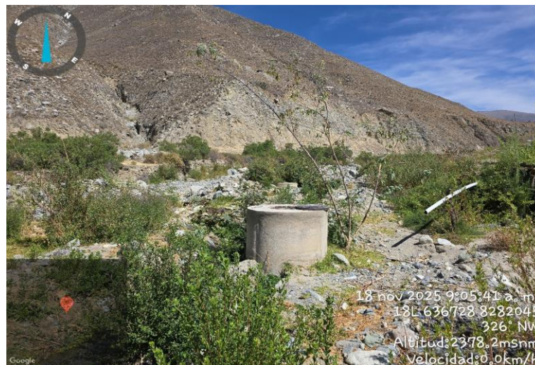
FIGURA N°03: EL AGUA PROVENIENTE DE LA GALERIA FILTRANTE SE ALMACENA EN EL RESERVORIO LA TOMA de capacidad de 400 m3.
